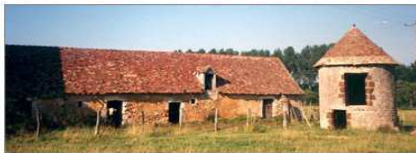
Four à chanvre dans la Sarthe (cliché Paule Marie Jullien - www.snv.jussieu.fr/ ). On distingue les deux entrées : une porte au rez de chaussée pour alimenter le feu, une porte plus haute pour remplir de chanvre la chambre de séchage.
